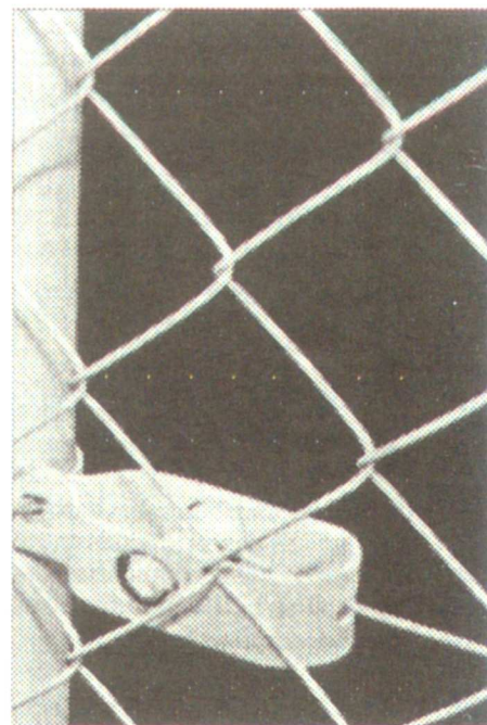
Obr. 2-8: Napínací element plotu.
